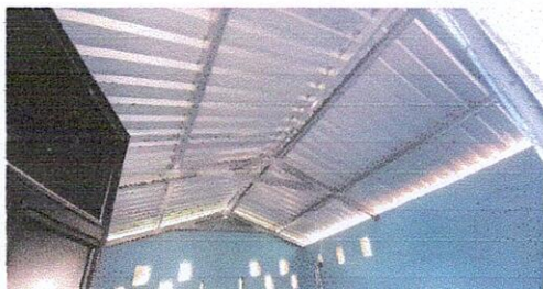
Foto 5: cambio de lamina en cocina
