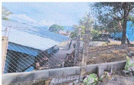
Foto 1: Cambio de base y sustitución de malla
