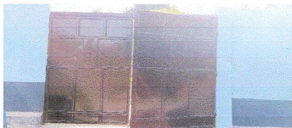
Foto 6: Reparación de portón
